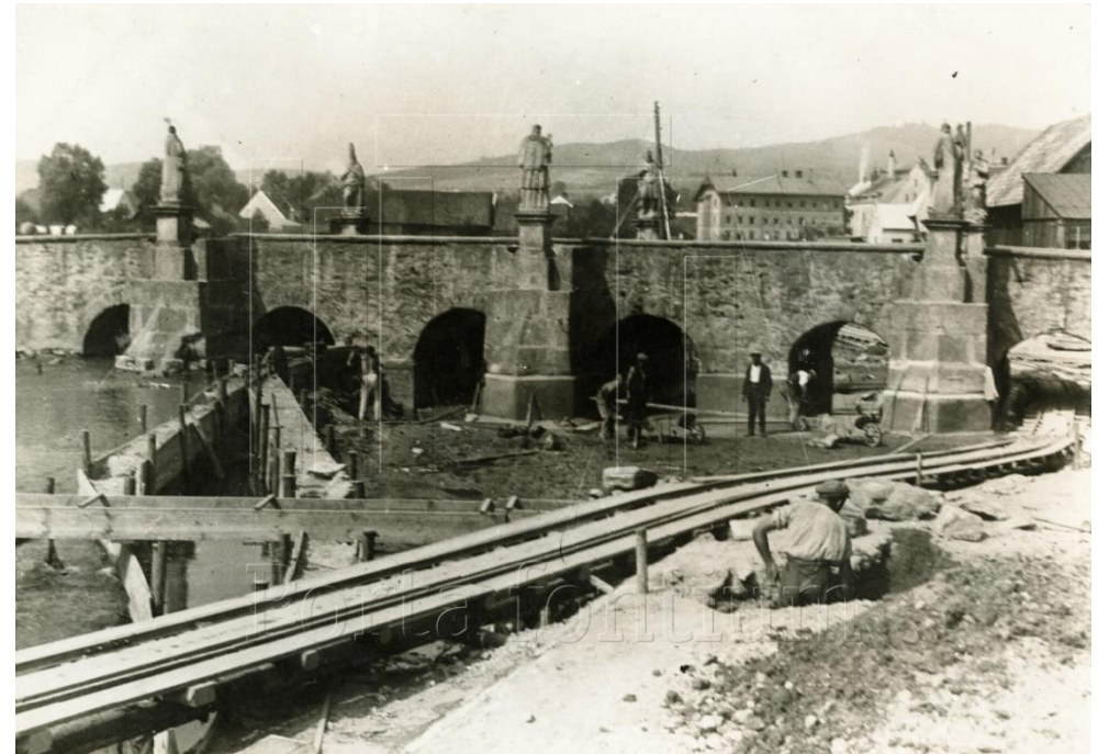
Bělá nad Radbuzou (Weißensulz), Brückenreparatur und Flussregulierung, um 1900. [SOkA Domažlice, Sammlung der Photographien, Sign. 54a/1; online: https://www.portafontium.eu/iipimage/30140385 ]
